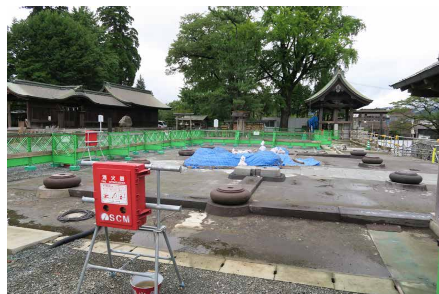
写真6 解体が終了した阿蘇神社の楼門(20180901)
