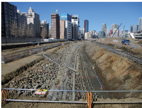
3 海側（東側）石垣〔明治5年（1872）〕（南から）
