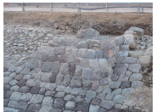
6 信号機跡（海側・東側から）
