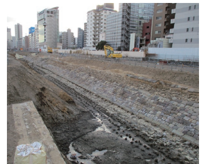
2 海側（東側）石垣〔明治5年（1872）〕（北から）
