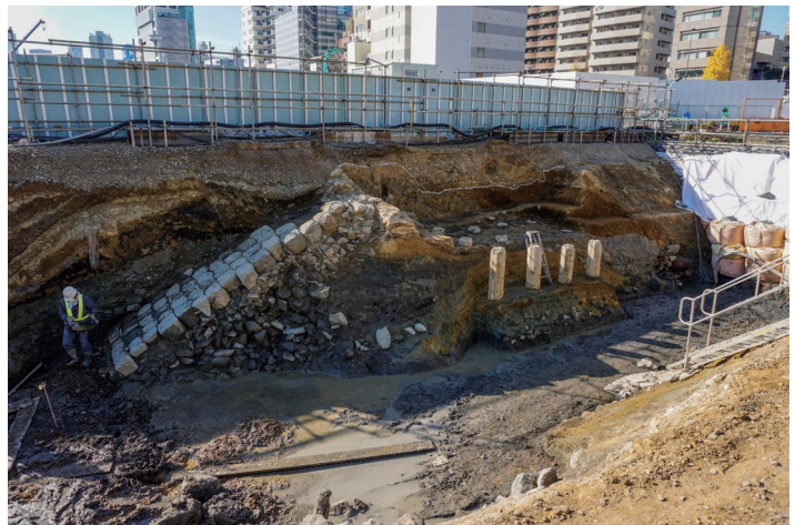
先行調査部1の堤体断面（青木撮影） 左端に浸透する海水を排水する捨て石がみえる。海側（左側）の堤体斜面は30°前後と、品川台場に比べると緩やかだ。
