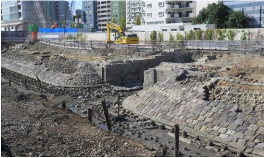
現在の橋梁部の様子
