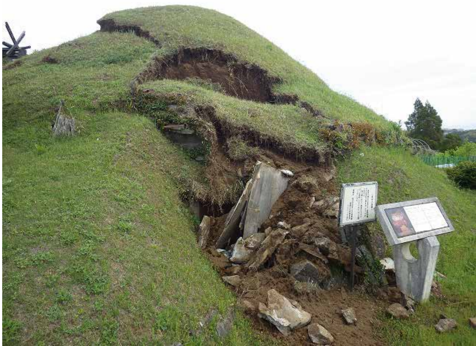
写真10 崩落した釜尾古墳の墳丘(熊本市撮影)
