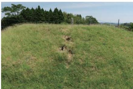
写真1 墳丘盛土に亀裂が発生した三段塚古墳（塚原古墳群内）(20160522)
