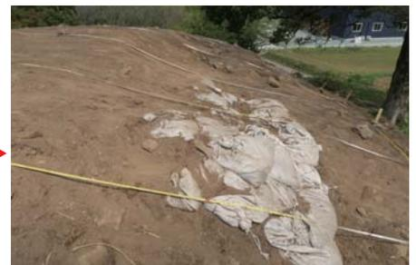
写真6 発災3年後の井寺古墳の墳丘亀裂箇所および墳丘盛土の極度の乾燥(20190328)
