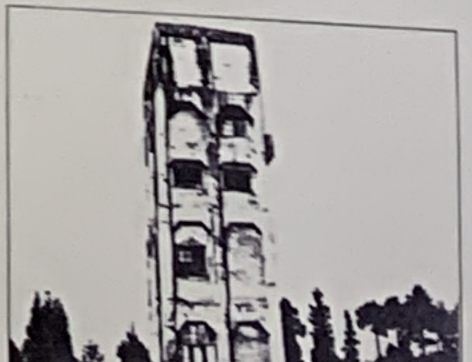
櫛引工場の給水塔写真
